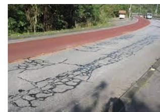
道路橋の劣化に与える影響について、国が実施した実験結果によると、軸重20トンの車1台が走行すると、10トン車の約4,000台相当となります。積載重量を超過した違法な大型車両が僅か0.3%であっても道路橋の劣化の約9割以上を引き起こしています。
